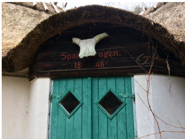
Figur 4. Nabohuset til Bohrs sommerhus.
