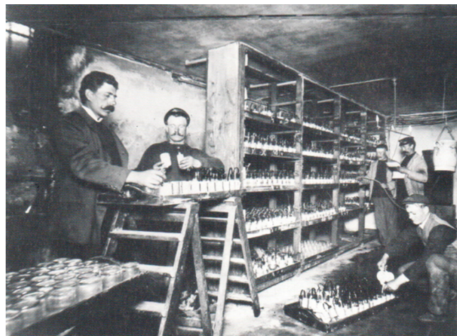
Figur 9. Batterikælderen i hovedtelegrafstationen i Købmagergade omkring 1895, hvor Leclanché-elementerne skulle vedligeholdes.
